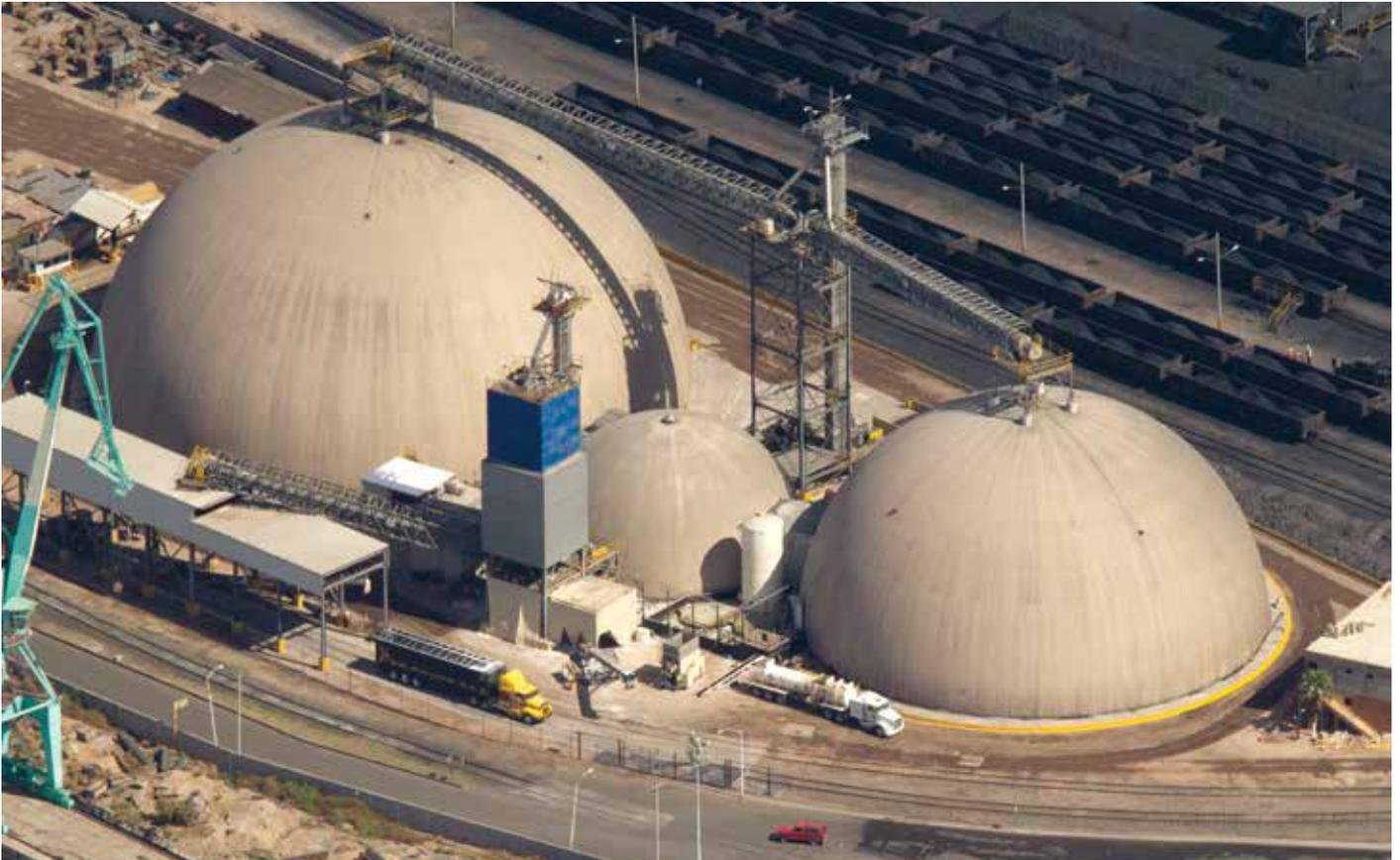
Instalaciones particulares de Cesionarios en el recinto portuario de Guaymas cuentan con equipo especializado para el manejo y almacenaje en domos de fertilizantes granulados, con capacidad dinámica de 2 millones de toneladas anuales, equipado con sistema automatizado de carga de tolvas de ferrocarril, instalación de mezcladora de fertilizantes y báscula para camión.
